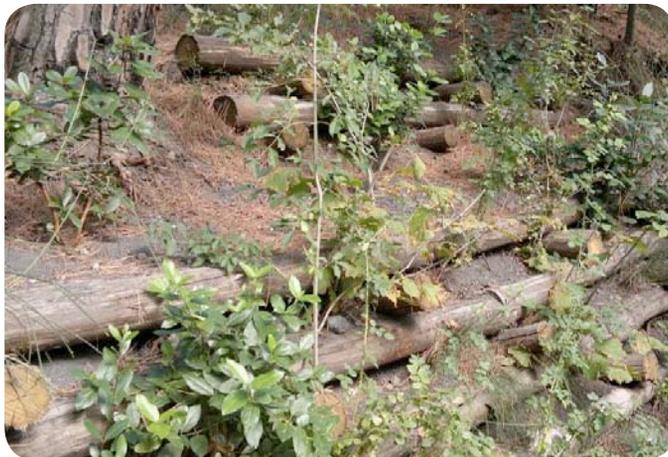
Photo 3.4 : Caisson en bois avec double paroi vivante (type Vesuvio).
