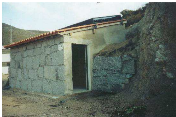
Séchoir solaire (source INRB - Portugal)
